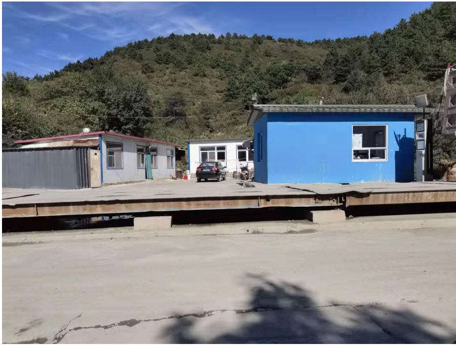
施工生产生活区地面硬化
