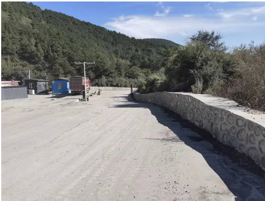
运输道路一侧浆砌石挡墙
