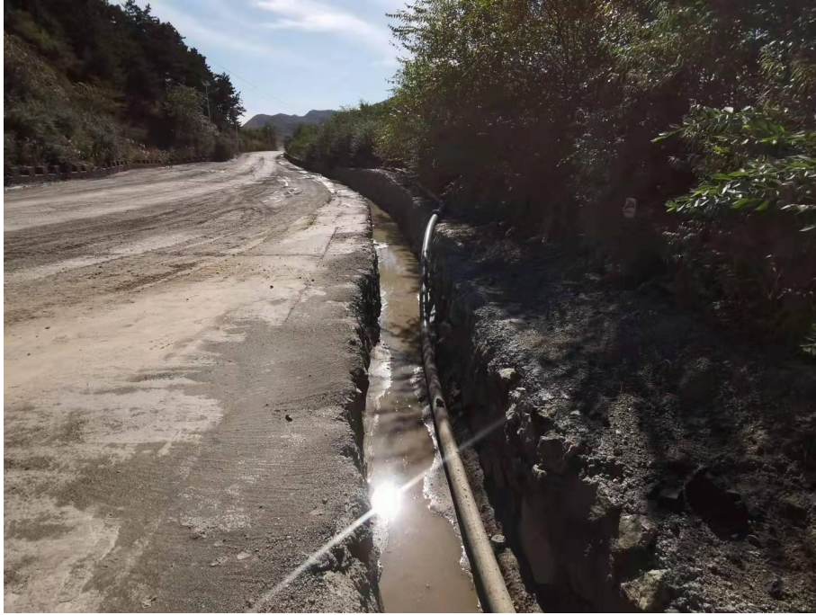
运输道路一侧浆砌石排水沟
