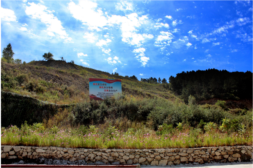
运输道路浆砌石挡墙
