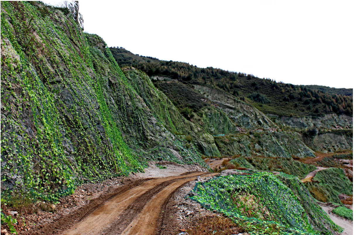
开采工业区挂网护坡
