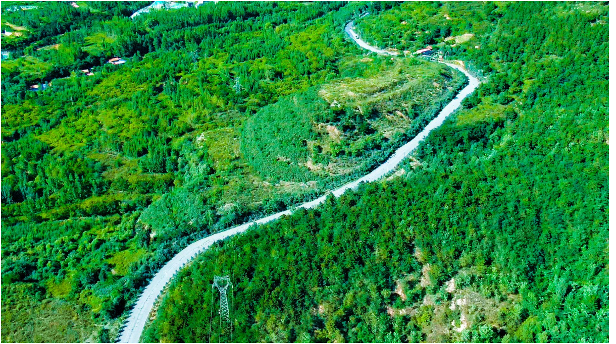
罗锅子沟排土场绿化
