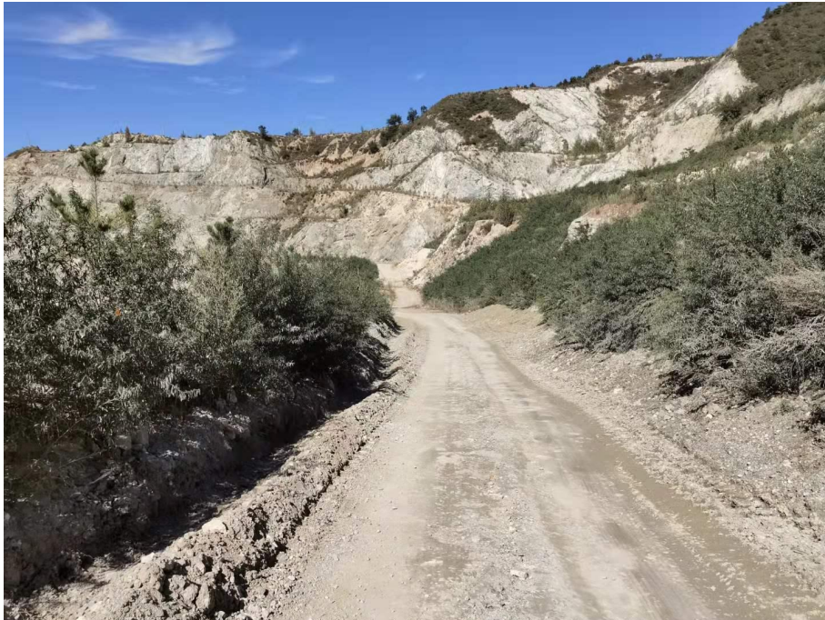
运输道路一侧土质排水沟
