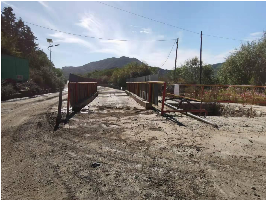
运输道路出口处沉淀池
