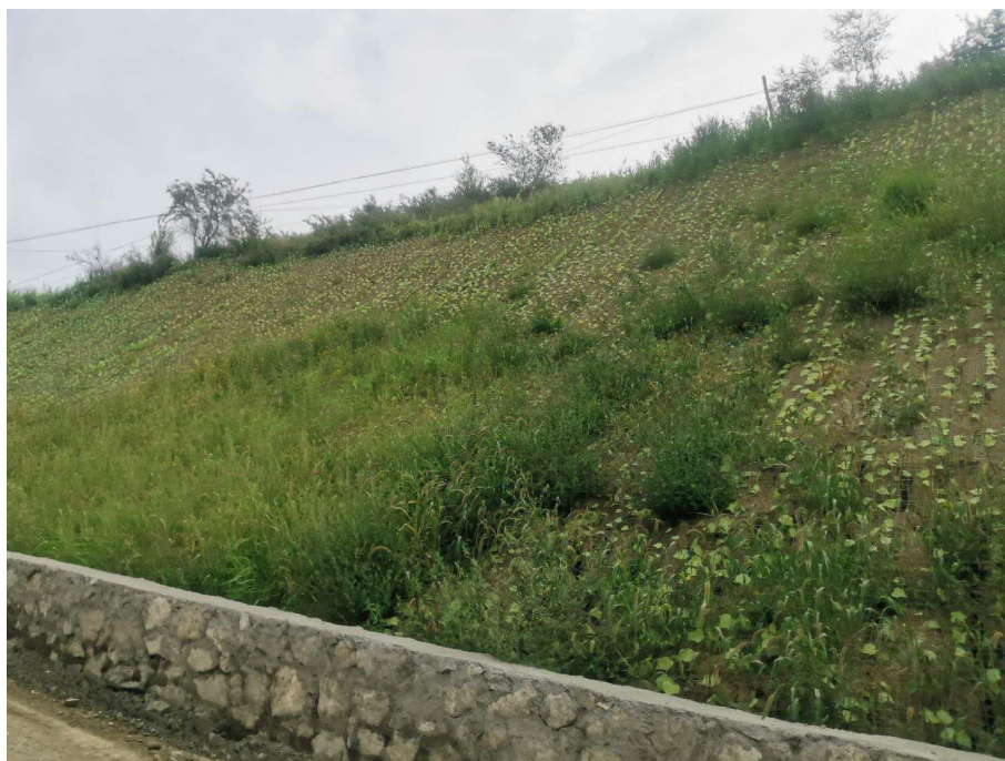
边坡绿化及浆砌石挡墙
