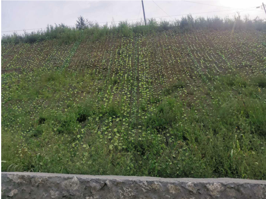
边坡挂网护坡
