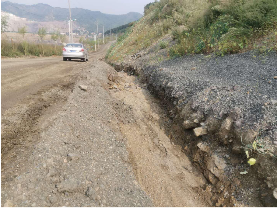
矿山道路一侧排水沟
