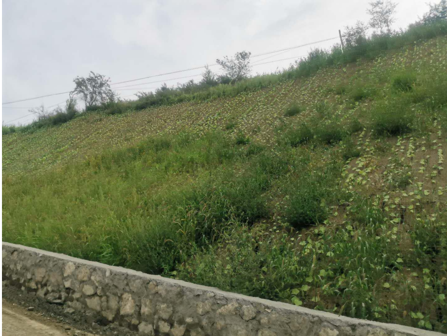
边坡绿化及浆砌石挡墙
