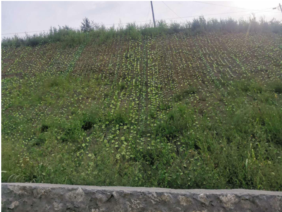
边坡挂网护坡
