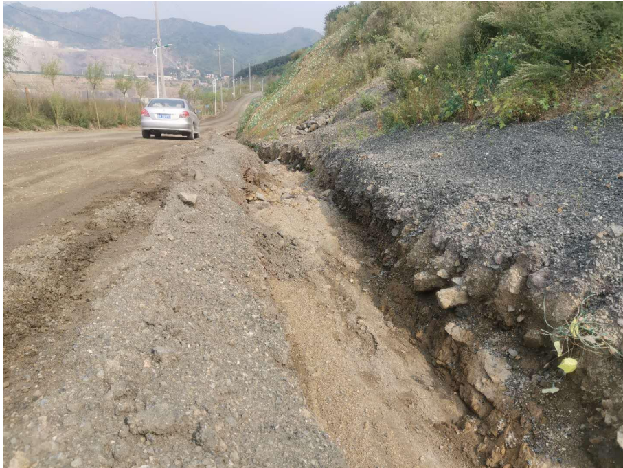
矿山道路一侧排水沟
