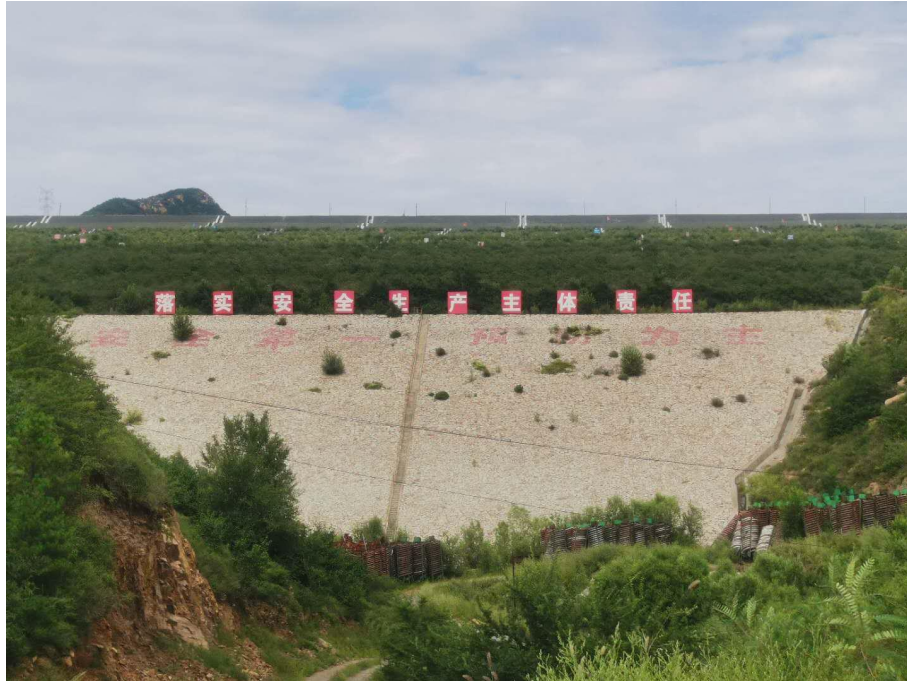
尾矿库初期坝
