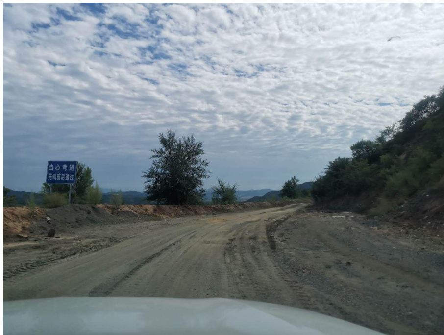
上坝道路一侧土质挡梗
