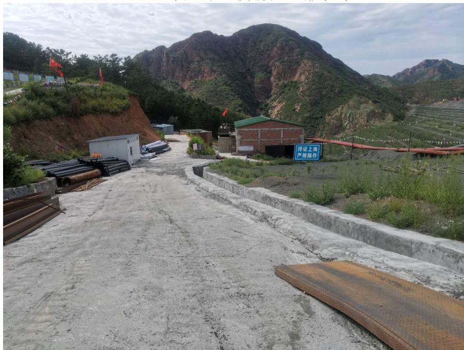
上坝道路一侧混凝土排水沟
