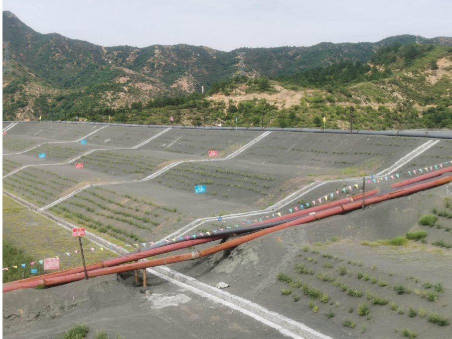
尾矿库坝坡浆砌石排水沟
