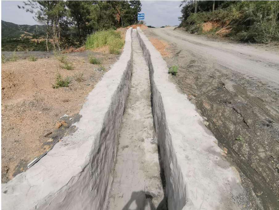
上坝道路一侧混凝土排水沟
