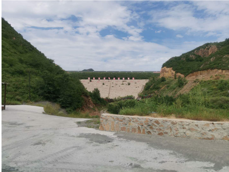
进厂道路一侧浆砌石挡墙
