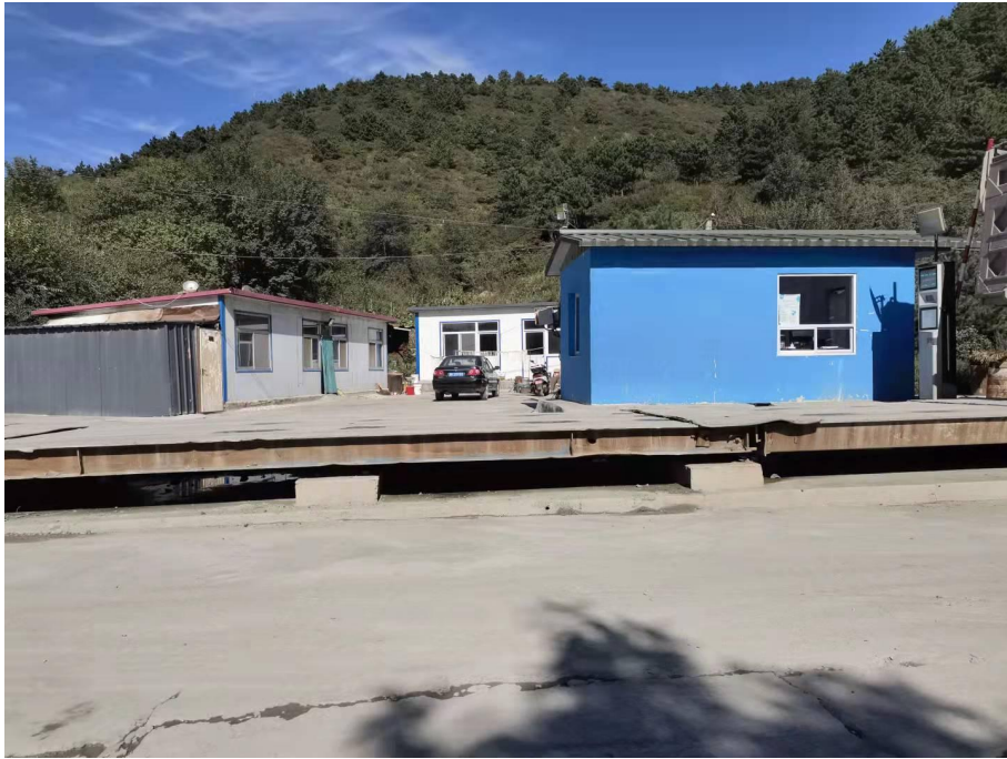
施工生产生活区地面硬化
