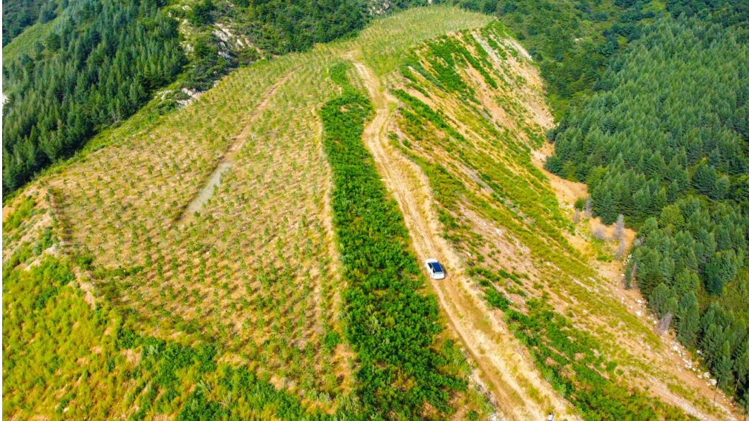
罗锅子沟排土场绿化
