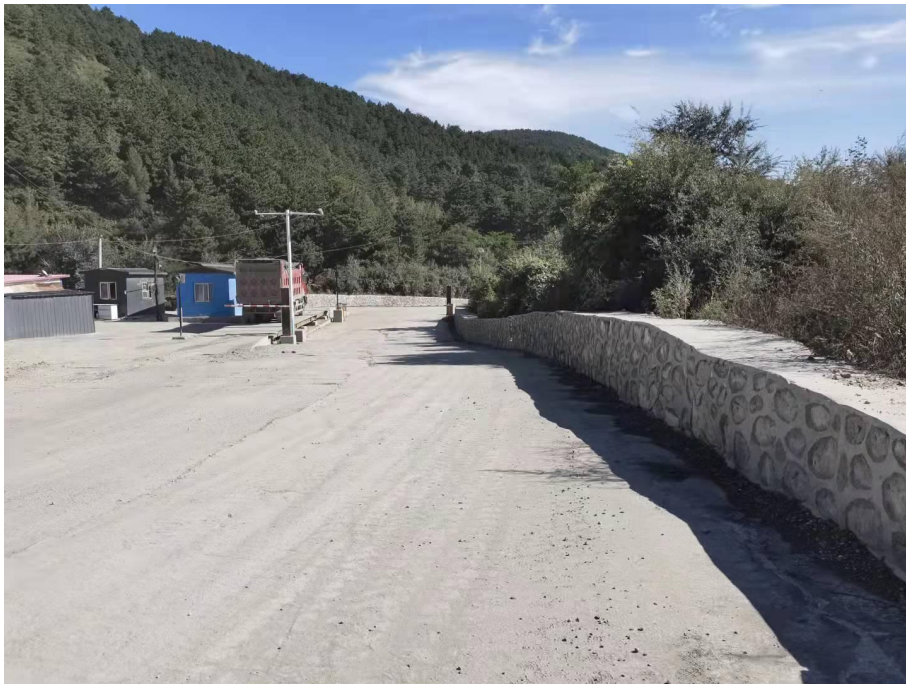
运输道路一侧浆砌石挡墙
