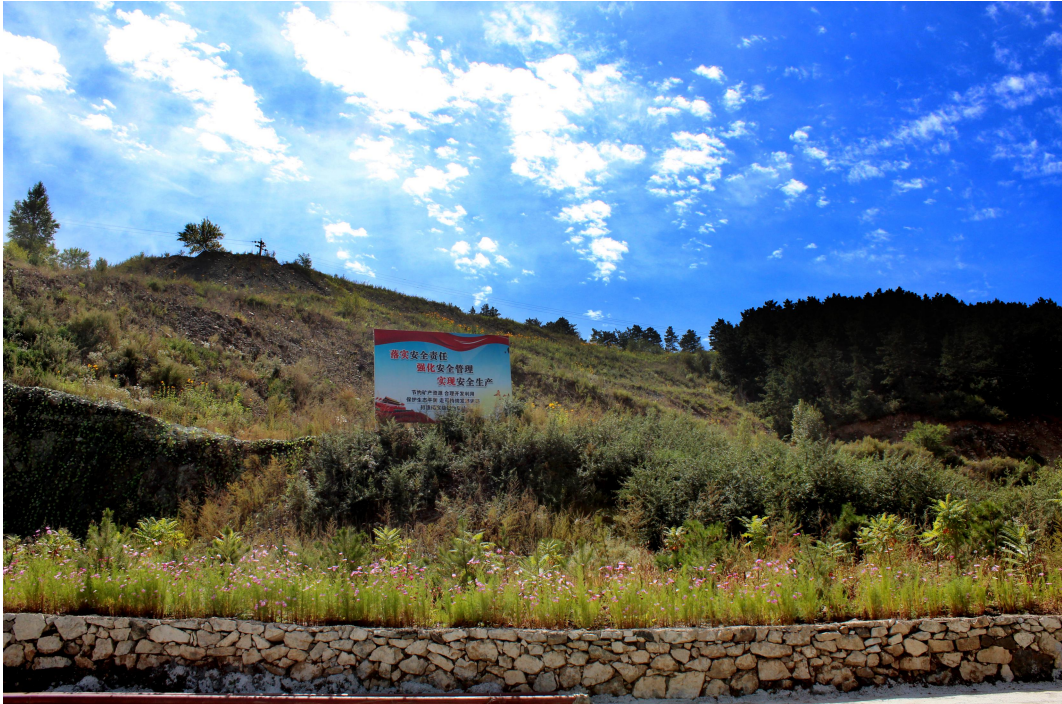
运输道路浆砌石挡墙
