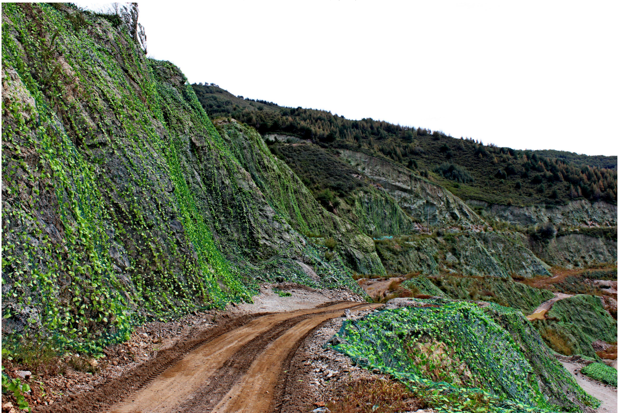
开采工业区挂网护坡
