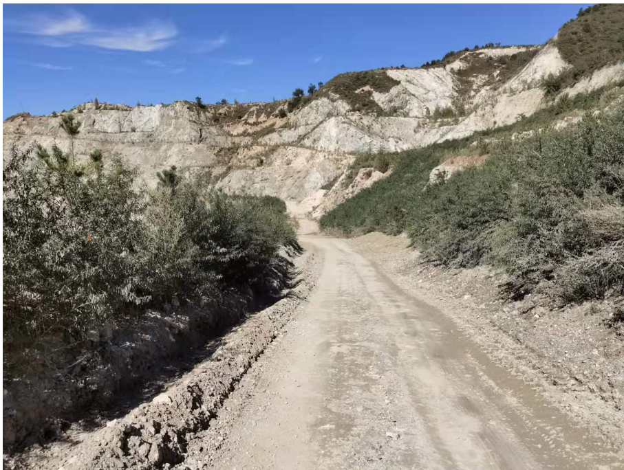
运输道路一侧土质排水沟
