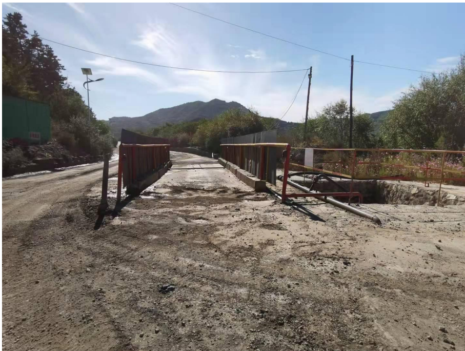
运输道路出口处沉淀池
