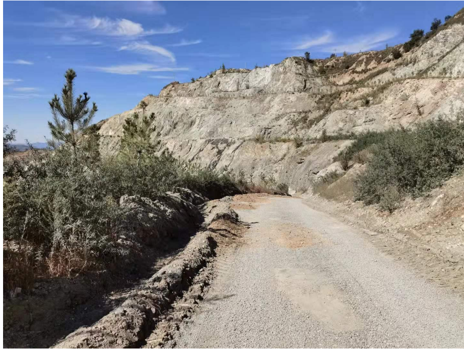
运输道路一侧土质排水沟
