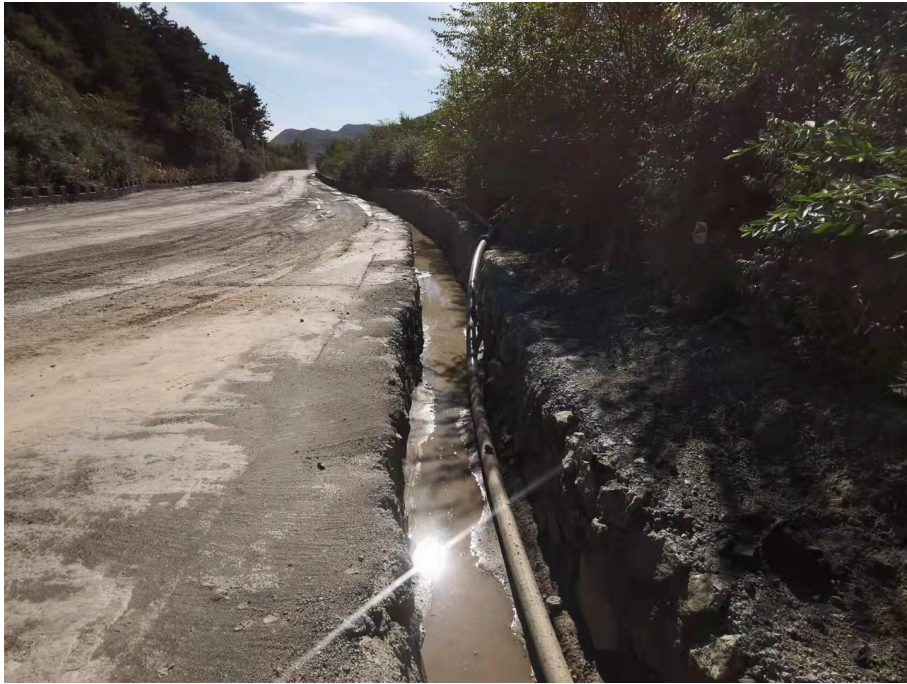
运输道路一侧浆砌石排水沟
